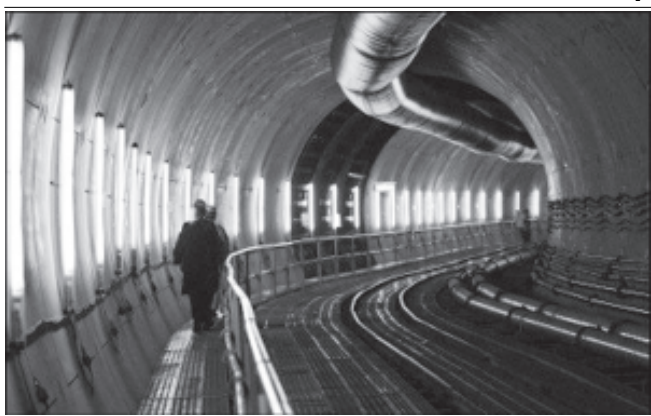
ဂျပန်နိုင်ငံအစိုးရသည် ဖြစ်ပေါ်လာနိုင်စရာရှိသော ငလျင်များ၏ ဘေးအန္တရာယ်ကိုရင်ဆိုင်ရန် ဆောင်ရွက်လျက်ရှိရာ တိုကျိုမြို့လယ်ကောင် မြေအောက်၌ တည်ဆောက်လျက်ရှိသော လိုဏ်ခေါင်းတစ်ခုကို မတ် ၂၀ ရက်က တွေ့ရစဉ်။
