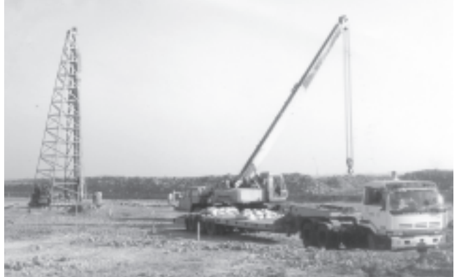
ရန်ကုန်မြို့တော် ရေပေးဝေရေးစီမံကိန်း(ငမိုးရိပ်)ဝင်းအတွင်း၌ အနည်ထိုင်ကန်နှင့် ရေစစ်ကန်များ ရေရှည်တည်တံ့ကြံ့ခိုင်ရေးအတွက် ဝိုင်းရံထားသည့်လုပ်ငန်းများ ဆောင်ရွက်နေစဉ်။
