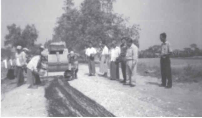
ဒီဇင်ဘာ ၃၁ရက်က ထားဝယ်မြို့ ဆိပ်ကမ်းသာလမ်း ထပ်မံ ကမ္ဘာ့ရောင်းချခြင်းကို ခရိုင်ဥက္ကဋ္ဌ ဒုတိယဗိုလ်မှူးကြီးခင်မောင်ညိုနှင့် မြို့နယ် ဥက္ကဋ္ဌတို့ ကြည့်ရှုစစ်ဆေးရာ အမှုဆောင်အရာရှိ ဒုတိယညွှန်ကြားရေးမှူး ဦးကြည်သန်းနှင့် တာဝန်ခံအင်ဂျင်နီယာဦးထွန်းထွန်းနိုင်တို့ ရှင်းလင်း တင်ပြကြစဉ်။ (မြို့နယ်စည်ပင်)
