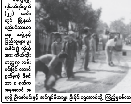
မကျေးမြို့ ရန်ပယ်ရပ်ကွက် (၂၂) လမ်း တွင် မြို့နယ် စည်ပင်သာယာရေး အဖွဲ့နှင့် ပြည်သူများ ပူးပေါင်း၍ ကိုယ့်အား ကိုယ်ကိုး ကမ္ဘာ့ရာ လမ်း ခင်းခြင်းဆောင်ရွက်မှုကို ဒီဇင်ဘာ ၈ ရက်က အမှုဆောင် အရာရှိ ဦးစောဝင်းနှင့် အင်ဂျင်နီယာမှူး ဦးစိုးခိုင်တို့ ကြည့်ရှုစစ်ဆေးကြသည်။ (မြို့နယ်စည်ပင်)
