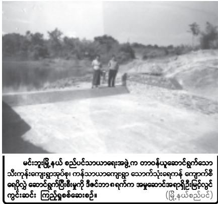
မင်းဘူးမြို့နယ် စည်ပင်သာယာရေးအဖွဲ့က တာဝန်ယူဆောင်ရွက်သော သီးကျန်းကျေးရွာအုပ်စု၊ ကန်သာယာကျေးရွာ သောက်သုံးရေကန် ကျောက်စီရေလှံသွားဆောင်ရွက်ပြီးစီးမှုကို ဒီဇင်ဘာ ၈ ရက်က အမှုဆောင်အရာရှိဦးမြင့်လွင်ကွင်းဆင်း ကြည့်ရှုစစ်ဆေးစဉ်။ (မြို့နယ်စည်ပင်)
