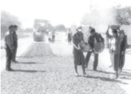
တပ်ကုန်းမြို့နယ် စည်ပင်သာယာရေးအဖွဲ့က ကျေးရွာချင်းဆက် လမ်းနှင့် ကမ္ဘာ့ရာလမ်းခြင်းလုပ်ငန်းဆောင်ရွက်မှုကို ဒီဇင်ဘာ ၆ ရက်က စည်ပင်သာယာရေးဦးစီးဌာန(ရုံးချုပ်)မှ ညွှန်ကြားရေးမှူး(အင်/ယာ) ဦးကျော် မြင့် ကြည့်ရှုစစ်ဆေးရာ အမှုဆောင်အရာရှိ ဘာဝန်ခံအင်ဂျင်နီယာတို့က လုပ်ငန်းဆောင်ရွက်မှု အခြေအနေများ ရှင်းလင်းတင်ပြစဉ်။ (၂၆၆)
