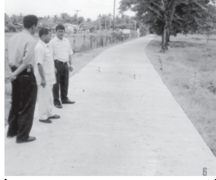
ဩဂုတ် ၇ရက်က ရန်ကုန်တိုင်း စည်ပင်သာယာရေးအဖွဲ့၊ ညွှန်ကြားရေးမှူး ဦးကြည်တင်ဆောင် ကျောက်တန်းမြို့နယ် စနောင်ကျေးရွာတွင် နီလားလမ်း၊ ဘိုးရာစာလမ်း၊ သီရိလမ်းနှင့် မဟာသုဝေလမ်းများ လမ်းချဲ့ထွင်ခြင်းနှင့် အဆင့်မြှင့်တင်ခြင်း လုပ်ငန်းများ ဆောင်ရွက်ပြီးစီးမှုကို ကျင်းပသောအခါ အမှုဆောင်အရာရှိ ဦးကြည်တင်နှင့် တာဝန်ခံအင်ဂျင်နီယာတို့ ရှင်းလင်းပြသကြစဉ်။ (မြို့နယ်စည်ပင်)
