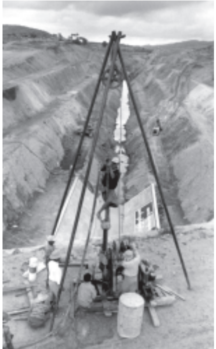
ဇူလိုင် ၁၆ ရက်က တောင်ရေချောင်း ရေလှောင်တံစပ် ရာနှုန်းပြည့်ပြီးစီးပြီးစီးနေသည့် ရေလွှဲဥမင်ဆက်သွယ်မြောင်းကြီးအား သတ္တန်ဖုတ်သွင်းခြင်းနှင့် ဂေဟဗျူဟာများဖြင့် အချောသပ်လုပ်ငန်းများ ဆောင်ရွက်နေစဉ်။ ဓာတ်ပုံ-သီန်းဝင်းဆေး (မြန်မာ့အလင်း)
