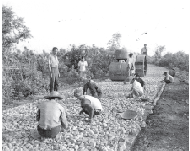
ကချင်ပြည်နယ် ဗန်းမော်မြို့နယ်အတွင်းရှိ ကျေးလက်လမ်းများ ပိုမိုကောင်းမွန်စေရန် စည်ပင်သာယာရေးအဖွဲ့က ဝက်ကုန်း-မံဇာ ကျေးရွာချင်းဆက်လမ်းကို ဤသို့ကျောက်ချာခင်း ဆောင်ရွက်ပေးခဲ့သည်။ (ဓာတ်ပုံမှတ်တမ်း-နယ်စပ်/စည်ပင်)
