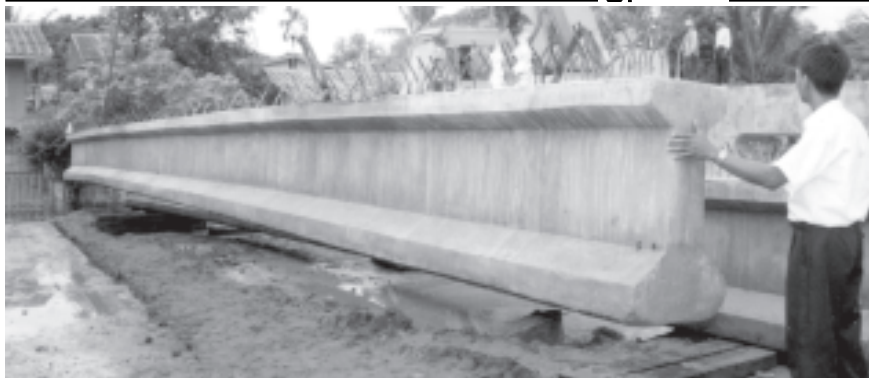
ရထားပို့ဆောင်ရေးဝန်ကြီးဌာနမှတည်ဆောက်လျက်ရှိသော ပါရမီရုံးကျော်တံတား ပိုင်တိုင်အမှတ်(၉)နှင့်(၁၀)အကြားတွင် ၅၇ ပေ တံတား ရက်မပေါင် တပ်ဆင်ခြင်းလုပ်ငန်းခွင်ကို တွေ့ရစဉ်။
