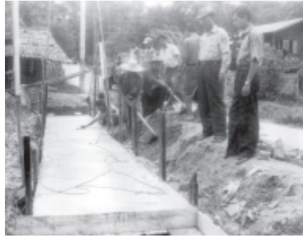
မေ ၂၆ ရက်က ငပုတောမြို့ ရေစီးရေလာကောင်းမွန်ရေးအတွက် ဗိုလ်တေလမ်းမြောင်းကူးတံတား အလျားပေ ၃၀၊ အကျယ် ၄ ပေ အမြင့် ၄ ပေ တည်ဆောက်ခြင်းလုပ်ငန်းကို ငပုတောမြို့နယ် စည်ပင်သာယာရေး အမှုဆောင်အရာရှိ ဦးအောင်ဌေးနှင့်အငယ်တန်းအင်ဂျင်နီယာ (၂) (မြို့ပြ) ဦးအောင်ကိုကိုတို့ အနီးကပ်ကြည့်ရှုဆောင်ရွက်ပေးကြစဉ်။
