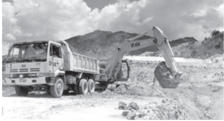
မွန်ပြည်နယ် မော်လမြိုင်မြို့နယ်တွင် လယ်ယာစိုက်ပျိုးရေးနှင့်ဆည်မြောင်းဝန်ကြီးဌာန ဆည်မြောင်းဦးစီးဌာန တည်ဆောက်ရေး(၆)မှ တာဝန်ယူ တည်ဆောက်လျက်ရှိသည့် ကတိုက်ရေလှောင်တံခွန်စီမံကိန်းတွင် စက်ယန္တရားများဖြင့် တစ်မြေမြေလုပ်ငန်းဆောင်ရွက်နေစဉ်။
