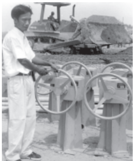
ဆည်မြောင်းဦးစီးဌာန တည်ဆောက်ရေး(၆)က မွန်ပြည်နယ် ပေါင် မြို့နယ်တွင် တည်ဆောက်လျက်ရှိသည့် ကျူထောင်ရေထိန်းတံခါး၊ ကျူထောင်ရေလုပ်ငန်းစွင်တွင် ဦးစီးအရာရှိ ဦးစော်ဦး(၁) (မြို့)က ရေတံခါးအဖွင့်အပိတ်ပြုလုပ်သည့် Gear Box များအကြောင်း မြန်မာ့ အလင်းသို့ ဤသို့ရှင်းပြသည်။ ဓာတ်ပုံ-သိန်းဝင်းလေး(မြန်မာ့အလင်း)
