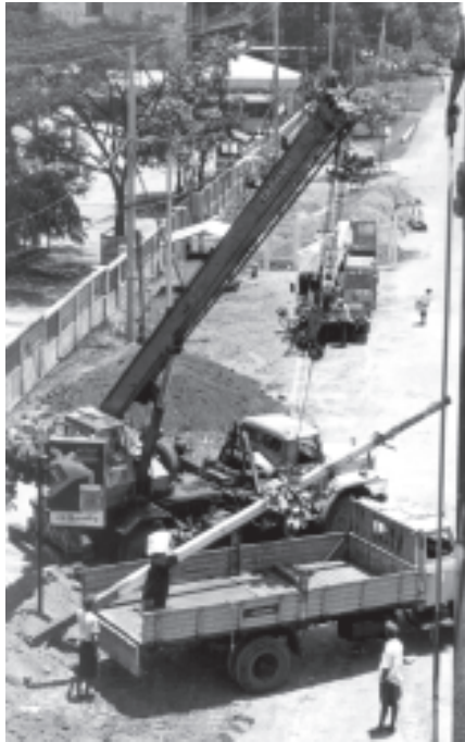
လျှပ်စစ်စွမ်းအားဝန်ကြီးဌာန ရန်ကုန်တိုင်း လျှပ်စစ်ဌာနမှ ဝန်ထမ်းများ ပါရမီနားကျော်တံတား တည်ဆောက်ရေးလုပ်ငန်းခွင်တွင် လူအား၊ စက်ယန္တရားစွမ်းအားတို့ဖြင့် မီးတိုင်များပြောင်းရွှေ့၍ အသစ်တပ်ဆင်နေသည်ကို တွေ့ရစဉ်။
