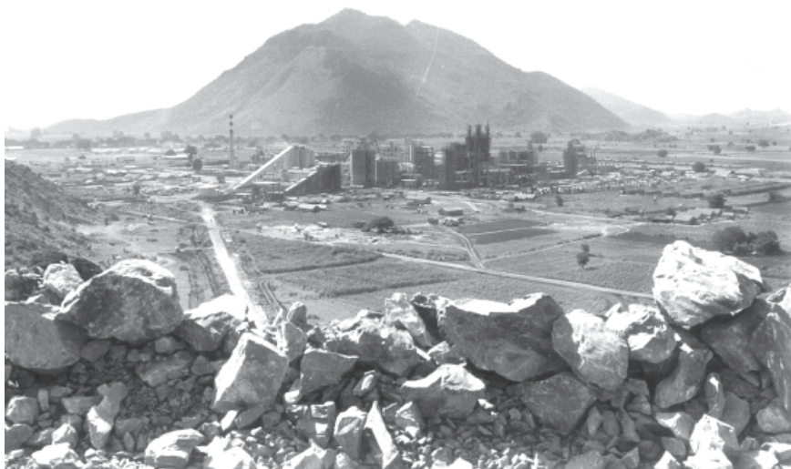
ကျောက်ဆည်မြို့အနီးရှိ နွားလည်ကောက်တောင်၌ ထုံးကျောက်ကုန်ကြမ်း အလုံအလောက်ထုတ်ယူသုံးစွဲနိုင်သည့် ကျောက်ဆည် ဆင်မင်းဘီလပ်မြေ စက်ရုံ။
