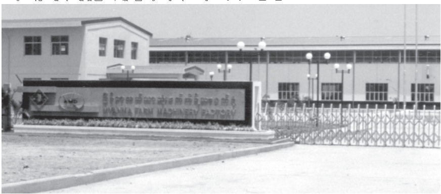
ကျောက်ဆည်မြို့နယ် အင်းကုန်းရွာရှိ မြန်မာ့လယ်ယာသုံး စက်ကိရိယာစက်ရုံ။
