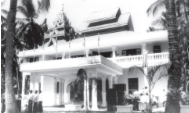
ဧရာဝတီတိုင်း ဝါးခယ်မမြို့၌ ရွှေသံလွင်ကုမ္ပဏီမီသားစုက ဆောက်လုပ်လှူဒါန်းသည့် ရွှေသံလွင်ပရိယတ္တိ ကျောင်းတိုက်အဆောက်အအုံကို ဝေ့ရစဉ်။
