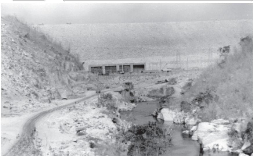
ပေါင်းလောင်းရေလှောင်တံ တက်စီမံကိန်းကို ပျဉ်းမနားမြို့ အရှေ့ဘက် ၁၁ မိုင်အကွာ ပေါင်းလောင်းမြစ်ပေါ်တွင် တည်ဆောက်အကောင်အထည်ဖော်နေခြင်းဖြစ်သည်။ စီမံကိန်းပြီးစီးပါက လယ်ပြေက ၃၅၀၀ ခန့်ကို စိုက်ပျိုးရေးပေးနိုင်မည်အပြင် လျှပ်စစ်ဓာတ်အား နှစ်စဉ် ကီလိုဝပ်နာရီသန်းပေါင်း ၉၁၁ ထုတ်လုပ်ပေးနိုင်မည်ဖြစ်သည်။ ဓာတ်ပုံမှတ်တမ်း-သိန်းဝင်းလေး (မြန်မာ့အလင်း)
