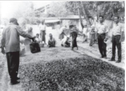
ဖေဖော်ဝါရီ ၂၀ ရက်က ကျိုက်လတ်မြို့နယ် စည်ပင်သာယာရေးအဖွဲ့မှ ၂၀၀၃-၂၀၀၄ ဘဏ္ဍာရေးနှစ်တွင် ပြည်သူ့နေမှုဆိုင်ရာ ဆောင်ရွက်လျက်ရှိသော ၄ လစာ ကဏ္ဍရာလမ်းခင်းခြင်းလုပ်ငန်းကို မြို့နယ်စည်ပင်သာယာရေးအဖွဲ့အမှုဆောင်အရာရှိ ဦးမြင့်မောင်နှင့် လက်ထောက်အင်ဂျင်နီယာ ဦးသိန်းဦးတို့က ကြီးကြပ်ဆောင်ရွက်ပေးခဲ့သည်။ (မြို့နယ်/စည်ပင်)
