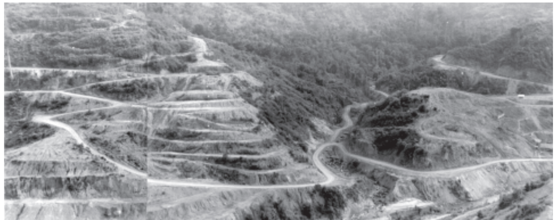
မြို့ရေလျှောင့်တစ်စီမံကိန်း တည်ဆောက်ရာတွင် လွယ်ကူဆောင်ရွက်ရန် တောတောင်များကို ခုတ်ထွင်ရှင်းလင်းခြင်းဖြင့် အကွေ့အကောက်လမ်းများ ဖောက်လုပ်ထားသည့်ကို ဤသို့တွေ့ရသည်။ (ဓာတ်ပုံမှတ်တမ်း-မောင်အောင်)
