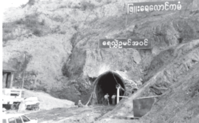
မြို့ရေလျှောင့်တစ်စီမံကိန်း ရေလွှဲဥမင်လိုက်အောင်တက် ဖောက်လုပ်ခြင်းလုပ်ငန်းကို ဤသို့ဆောင်ရွက်ခဲ့ကြသည်။ (ဓာတ်ပုံမှတ်တမ်း-မောင်အောင်)
