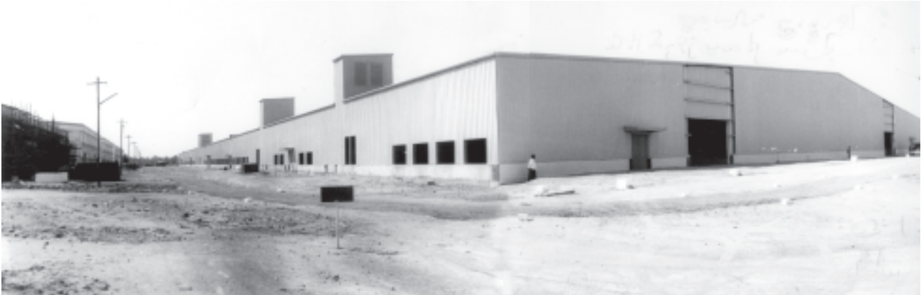
စစ်ကိုင်းတိုင်း ဆားလင်းကြီးမြို့နယ်ရှိ အမှတ်(၁)စက်မှုဝန်ကြီးဌာန မြန်မာ့အလင်းအလုပ်လုပ်ငန်း ဆားလင်းကြီးချည်မျှင်နှင့်အထည်စက်ရုံ တည်ဆောက်ရေးစီမံကိန်းပြီးစီးမှုကိုတွေ့ရစဉ်။ (သတင်းစဉ်)
