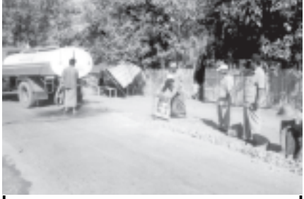
ဖေဖော်ဝါရီ ၅ ရက်က မြောင်းမြမြို့နယ် စည်ပင်သာယာရေးအဖွဲ့က ဆောင်ရွက်သည့် ကျွန်းတောင်လမ်း လမ်းပန်းခြံခြင်း၊ လမ်းပေါက်ဖျက်ခြင်းလုပ်ငန်းကို အသေးစား စီရိုက်စစ်ဖြင့် မြေထုခြင်း၊ ရေလျှော့မြင်းလုပ်ငန်းကို မြို့နယ်စည်ပင်သာယာရေးအဖွဲ့ အမှုဆောင်အရာရှိ ဦးစီမောင်းချီနှင့်တာဝန်ရှိသူများက ကြိုကြိုဆောင်ရွက်လျက်ရှိရာ ဧရာဝတီတိုင်း စည်ပင်သာယာရေးအဖွဲ့ ညွှန်ကြားရေးမှူး ဦးအုန်းသွင် ကြည့်ရှုစစ်ဆေးစဉ်။ (က-ပ)
