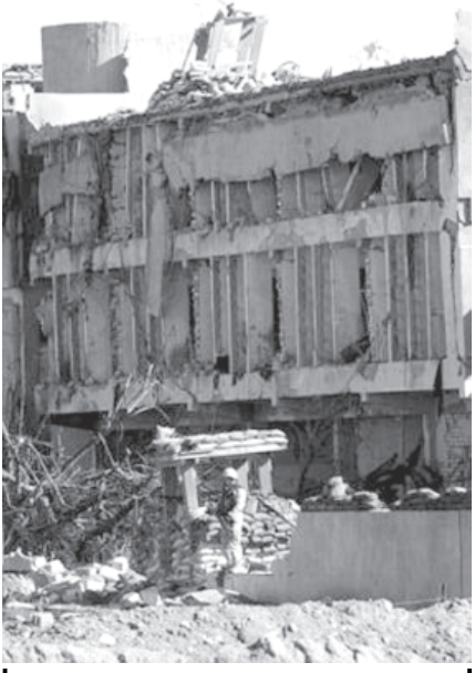
၂၀၀၃ ခုနှစ် ဒီဇင်ဘာ ၂၈ ရက်က ကာဘာလာမြို့ရှိ ကုလသမဂ္ဂ ဝန်ထမ်းနေရာကို ကားပုံးခွဲတိုက်ခိုက်ခံရပြီးနောက် ပျက်စီးနေသော အဆောက်အအုံကို ဆွေ့ရစဉ်။ (ယင်းတိုက်ခိုက်မှုတွင် ပူးပေါင်းတပ်ဖွဲ့ဝင် မြောက်ဦးသေဆုံးခဲ့ပြီး ဒဏ်ရာရရှိသူပေါင်း ၁၂ ဦးရှိသည်။) (ဓာတ်ပုံ-အင်တာနက်)
