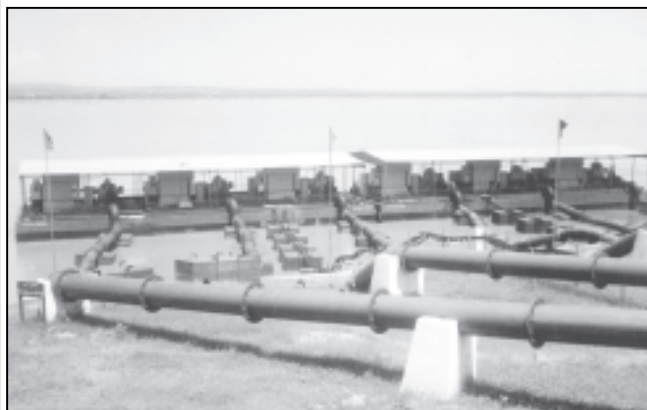
မကွေးတိုင်း စလေမြို့နယ်ရှိ ဥမင် ကျိုပေါက် မြစ်ရေတင် (ဧရာဝတီ) ရေပေါ် ရေတင် စက်ရုံများ။
