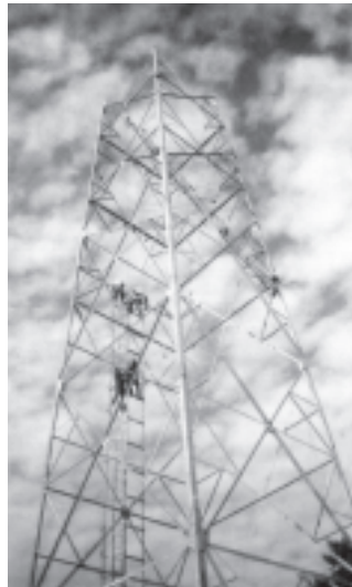
တာချီလိတ်မြို့တွင် မိုက္ကရိုဝေ့မီတာဝါ တည်ဆောက်ရေးလုပ်ငန်းများ ဤသို့ဆောင်ရွက်ခဲ့သည်။
