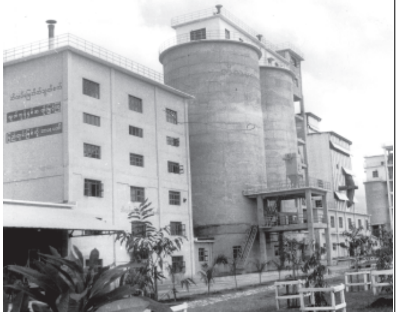
မန္တလေးတိုင်း ကျောက်ဆည်မြို့နယ် ကျောက်ဆည် စက်မှုနယ်မြေ၌ အမှတ် (၁) စက်မှုဝန်ကြီးဌာနက ၂၀၀၂ ခုနှစ်တွင် တည်ဆောက် အကောင်အထည်ဖော်ခဲ့သော တန် ၅၀၀ ကျော် ဘီလပ်မြေစက်ရုံကြီးကို တွေ့ရစဉ်။
