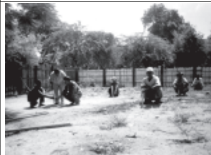
ဒီဇင်ဘာ ၁၇ ရက်က မကွေးမြို့နယ် ဓားကျေးရွာတွင် ကျေးလက်ဒေသ တန်ဖိုးနည်းဆိုင်ရာများ ဆောက်လုပ်ရန်အတွက် ပူးတွဲချက်ရာ အမှုဆောင် အရာရှိ ဒုတိယညွှန်ကြားရေးမှူး ဦးကြည်သန်းနှင့်တာဝန်ရှိသူများ ကြီးကြပ်ပေးစဉ်။ (မြို့နယ်စည်ပင်)
