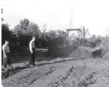
ဗန်းမော်မြို့နယ် စည်ပင်သာယာရေးအဖွဲ့ အမှုဆောင်အရာရှိ ဦးကျော်သူနှင့် တာဝန်ခံ အင်ဂျင်နီယာ ဦးမျိုးတို့ကိုင်ဘာ ၁၀ရက်က ဝက်ကုန်-မံမာ မြေအားလမ်းသစ်အား စက်ယန္တရားဖြင့် ဆောင်ရွက်မှုအား အနီးကပ်ကြီးကြပ်ဆောင်ရွက်ပေးစဉ်။
