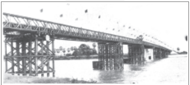
နိုင်ငံတော်က ကရင်ပြည်နယ် ဖွံ့ဖြိုးတိုးတက်ရေးအတွက် ကော့ကရိတ်မြို့နယ်တွင် ရှိုင်းမြစ်ကို ဖြတ်ကူးမည်ညောကုန်း ၁၇၉၉ ခုနှစ် မေလ ၂၂ ရက်က ဖွင့်လှစ်ပေးခဲ့သည့် ရှိုင်း (ကော့ကရိတ်)တံတားကို တွေ့ရစဉ်။
