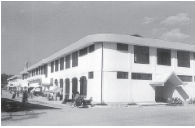
ကယားပြည်နယ် လွိုင်ကော်မြို့နယ်အတွင်း ကူးသန်းရောင်းဝယ်မှု လွယ်ကူ အဆင်ပြေစေရန်အတွက် တည်ဆောက်ပေးထားသည့် ကန္တာရဝတီနှစ်ထပ်ရောင်းသစ်ကြီး။
