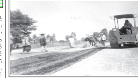
မကွေးမြို့နယ် စည်ပင်သာယာရေးအဖွဲ့ ဝန်ထမ်းများ မြို့တွင်းလမ်းများ ကောင်းမွန်ရေးအတွက် ဇွန် ၇ ရက်က စက်ယန္တရားများဖြင့် ဆောင်ရွက်ခဲ့သည်။
