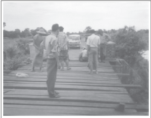
ပဲခူးတိုင်း မင်းလှမြို့နယ် စည်ပင်သာယာရေးအဖွဲ့က တောင်ကြိုကုန်း- သနာဗိုကျေးလက်လမ်းပေါ်ရှိ အောက်ကိုင်းကြီးတံတားဆောက်လုပ်ခြင်း လုပ်ငန်းကို အမှုဆောင်အရာရှိ ဦးဝင်းမောင်နှင့် လက်ထောက်အင်ဂျင်နီယာ ဦးတင်လင်းဦးတို့အဖွဲ့ ဇွန် ၂၈ ရက်က ကြီးကြပ်ဆောင်ရွက်စဉ်။ (မြို့နယ် ပြန်/ဆက်)
