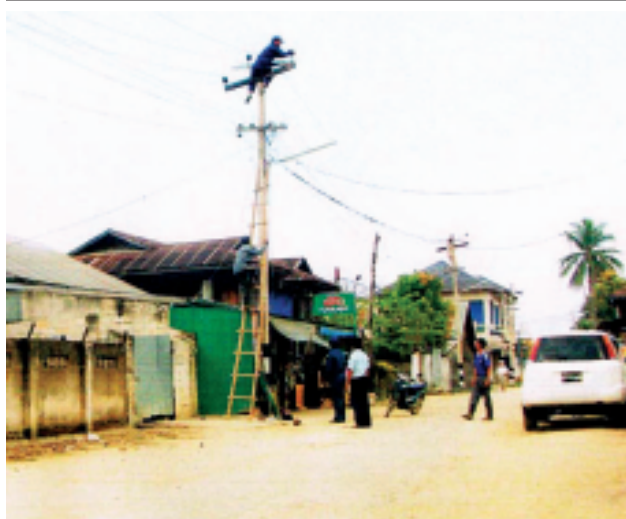
ရမ်းပြည်နယ်(အရှေ့ပိုင်း) မိုင်းဆတ်မြို့တွင် ဓာတ်အားစနစ် ကောင်းမွန်ရေးနှင့် လျှပ်စစ်အန္တရာယ်ကင်းရှင်းရေးအတွက် ခရိုင်လျှပ်စစ်အင်ဂျင်နီယာဦးညွန့်ဝင်းနှင့် မြို့နယ်လျှပ်စစ်အင်ဂျင်နီယာ ဦးဇော်ထွန်းတို့ ကြီးကြပ်၍ 11 KV ဓာတ်အားလိုင်းတွင် ဆွေးမြည့်သစ်သားတန်းများအား သံလက်တန်းဖြင့် အစားထိုးလဲလှယ်တပ်ဆင်ခြင်းလုပ်ငန်းကို ဖေဖော်ဝါရီ ၂၈ ရက် နံနက်က ဆောင်ရွက်နေစဉ်။ (ဝေယံလင်း - မိုင်းဆတ်)
