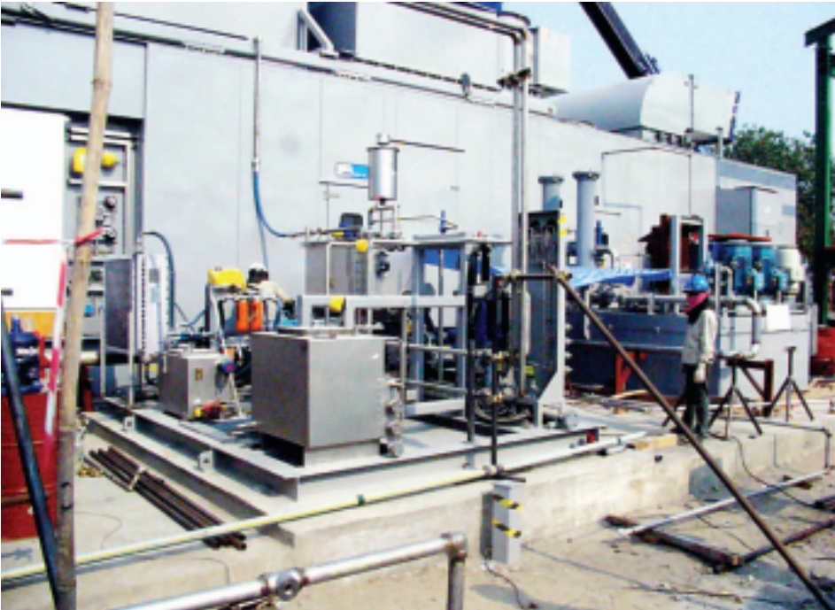
အလုံဓာတ်အားပေးစက်ရုံအတွင်း အသစ်တည်ဆောက်လျက်ရှိသော ဓာတ်အားပေးစက်ကို တွေ့ရစဉ်။(သတင်းစဉ်)
