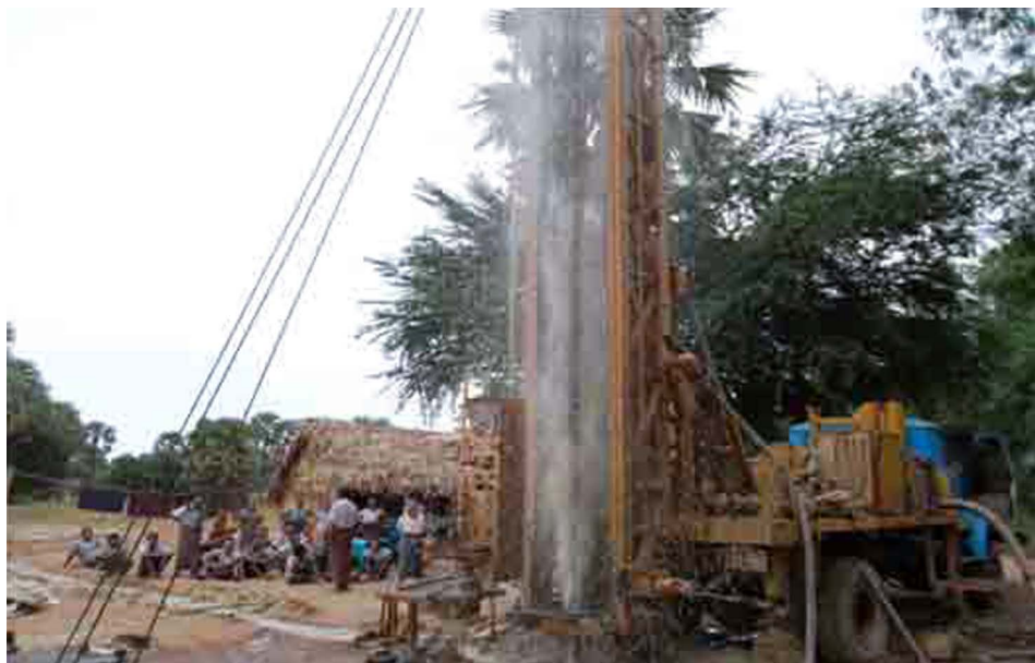
Well Developing ရေမျှတခြင်းလုပ်ငန်း ဆောင်ရွက်နေစဉ်။
