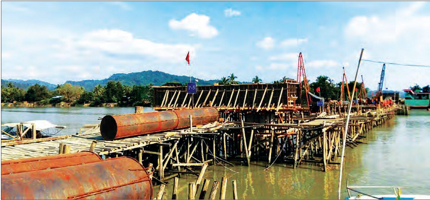
စိုင်းတင်တံတား တည်ဆောက်ရေးစီမံကိန်းလုပ်ငန်းခွင်ကို တွေ့ရစဉ်။
