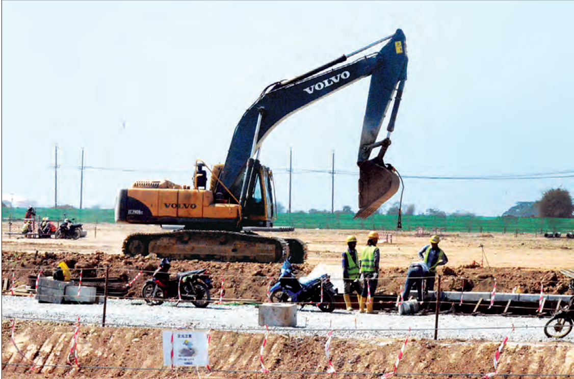
သီလဝါအထူးစီးပွားရေးဇုန် (အပိုင်း-ခ) ပထမအဆင့် ဟက်တာ ၁၀၁ (ဧက ၂၅၀) အကောင် အထည်ဖော်ဆောင်ရွက်နေမှုကို တွေ့ရစဉ်။
