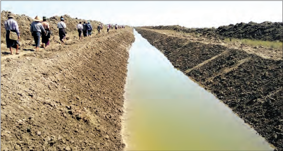
ပင်လယ်ဝအထိ တူးဖော်ရေးလုပ်ငန်း ဆောင်ရွက်နေသည့် မရမ်းကုန်းရေတံခါးတူးမြောင်းကို တွေ့ရစဉ်။
