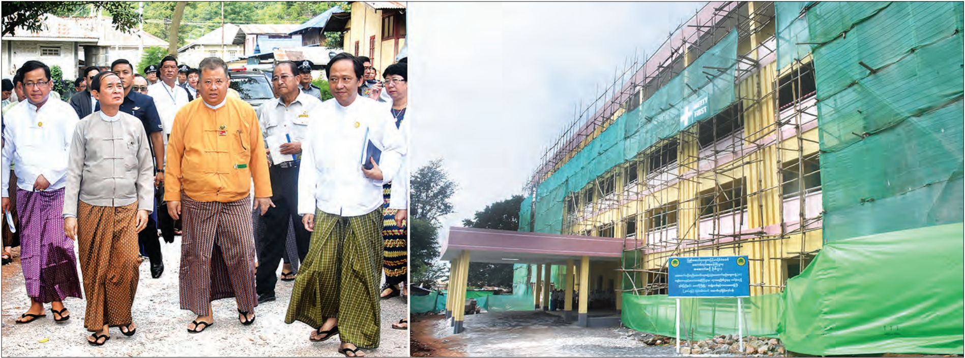
နိုင်ငံတော်သမ္မတ ဦးဝင်းမြင့် တောင်ကြီးမြို့အမျိုးသမီးနှင့် ကလေးဆေးရုံလေးထပ်ဆောင် တည်ဆောက်နေမှုကို ကြည့်ရှုစဉ်။ သတင်းစဉ်
