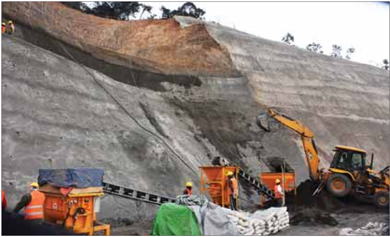
ကလေး-ဖလမ်း-ဟားခါးလမ်း မိုင်တိုင် (၈၅/၂) နှင့် (၈၅/၃) အကြား မြေထိန်းနံရံတည်ဆောက်မှုလုပ်ငန်းခွင်ကို တွေ့ရစဉ်။
