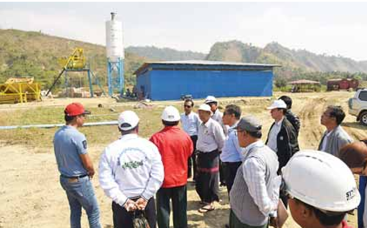
ပြည်နယ်ဝန်ကြီးများနှင့်အဖွဲ့ အမှုဆောင်-မောင်တောလမ်းဆောင်ရွက်နိုင်ရန် Batching Plant ကွန်ကရစ်ဖျော်သည့်လုပ်ငန်းခွင်ကို ကြည့်ရှုစစ်ဆေးကြစဉ်။
