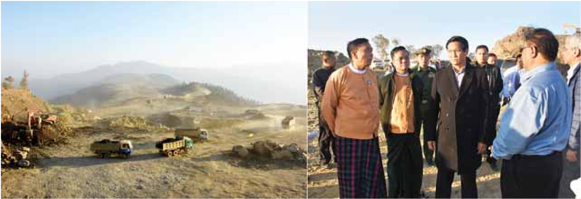
ပလမ်း(ဆူရ်ဘုန်)လေဆိပ်သစ်တည်ဆောက်ရေးစီမံကိန်းလုပ်ငန်းခွင်အား ဒုတိယသမ္မတ ဦးဟင်နရီဗန်ထီးယူ ကြည့်ရှုစစ်ဆေးစဉ်။
