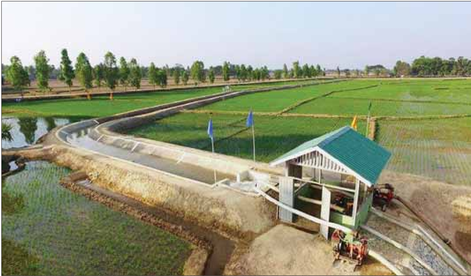
ကုန်းမြင့်လယ်မြေများတွင် နွေစပါးစိုက်ပျိုးနိုင်ရေး တောင်ငူမြို့ ခပေါင်းလက်ဝဲမြောင်းမကြီးမှ ရေကိုသွယ်ယူ၍ လျှပ်စစ်ရေတင်စနစ်ဖြင့် စိုက်ပျိုးရေးပေးဝေလျက်ရှိစဉ်။
