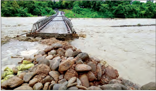
ယခုရက်ပိုင်းအတွင်း မိုးအဆက်မပြတ်ရွာသွန်းမှုကြောင့် ခမ်းပါတ်မြို့၌ ကန်ချောင်းတံတား တံတားအမှတ် (၃/၅၈)၏ မြောက်ဘက် ကမ်းကပ်ခုံမှာ ရေတိုက်စားပြတ်တောက် သွားသည်ကိုတွေ့ရစဉ် (အဆိုပါဖြစ်စဉ်ကြောင့် ကလေး-တမူး လမ်းပိုင်းတွင် ယာဉ်များသွားလာမှု ယာယီရပ်ဆိုင်းထားရကြောင်း သိရသည်။) ဇော်ဝင်းထွန်း (ပြန်/ဆက်)
