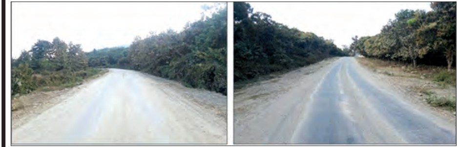
ကျောက်တော်-ပလက်ဝလမ်းအား ကတ္တရာလမ်းအဖြစ် အဆင့်မြှင့်တင်ခြင်းလုပ်ငန်း ဆောင်ရွက်ထားမှုကို တွေ့ရစဉ်
