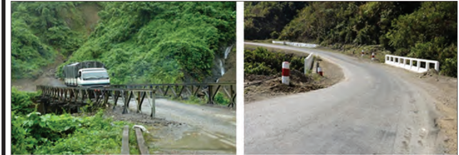
ဘူးသီးတောင်-မောင်တောလမ်း မိုင် (၆/၇-၇/၀) ကြား အရှည်ပေ ၄၀ တံတားအမှတ် (၁၃/၇) ကို သံကူကွန်ကရစ်တံတား တည်ဆောက်ခြင်း မဆောင်ရွက်မီပုံနှင့် ဆောင်ရွက်ပြီးနောက်တွေ့ရပုံ
