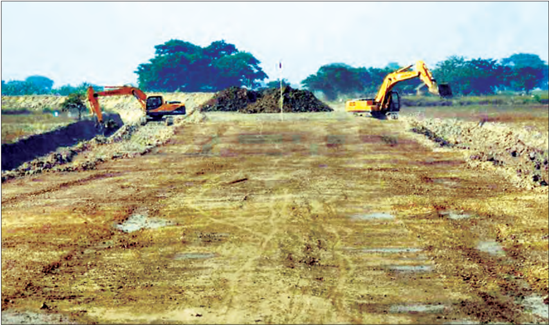
စစ်တောင်းမြစ်ရေလွှမ်းခြင်းမှ ကာကွယ်ရန် ရေလျှံထိန်းတာပေါင် တာဖို့ခြင်းလုပ်ငန်း ဆောင်ရွက်နေစဉ်
