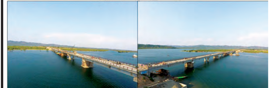
ပုဏ္ဏားကျွန်း-ရသေ့တောင်လမ်း တောဈားချောင်းတံတား အဆင့်မြှင့်တင်ဆောင်ရွက်သည့် အရှည် ၃၆၅ ဒဿမ ၇ မီတာ သံကူကွန်ကရစ်တံတား ဆောင်ရွက်ပြီးစီးမှုကို တွေ့ရစဉ်
