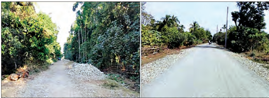
မာန်အောင်ကျွန်းပတ်လမ်း (၁၂ ကီလိုမီတာ - ၁၅ ဒဿမ ၂ ကီလိုမီတာ)အတွင်း မူလအမာခံလမ်းမှ အကျယ် ၁၂ ပေ ကတ္တရာလမ်းအဖြစ်သို့ အဆင့်မြှင့်တင်ဆောင်ရွက်ခြင်း မဆောင်ရွက်မီပုံနှင့် ဆောင်ရွက်ပြီးနောက် တွေ့ရပုံ
