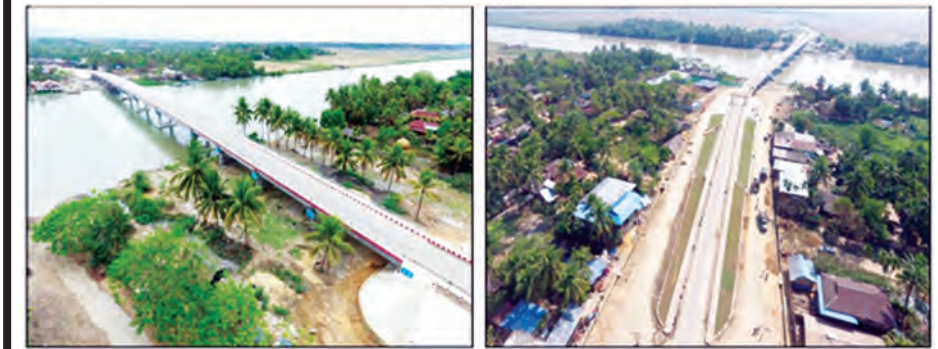
ရသေ့တောင်-ဘူးသီးတောင်လမ်း ပန်းဇင်းချောင်းတံတား အဆင့်မြှင့်တင်ဆောင်ရွက်သည့် အရှည် ၂၉၃ မီတာ သံကူကွန်ကရစ်တံတား ဆောင်ရွက်ပြီးစီးမှုကို တွေ့ရစဉ်
