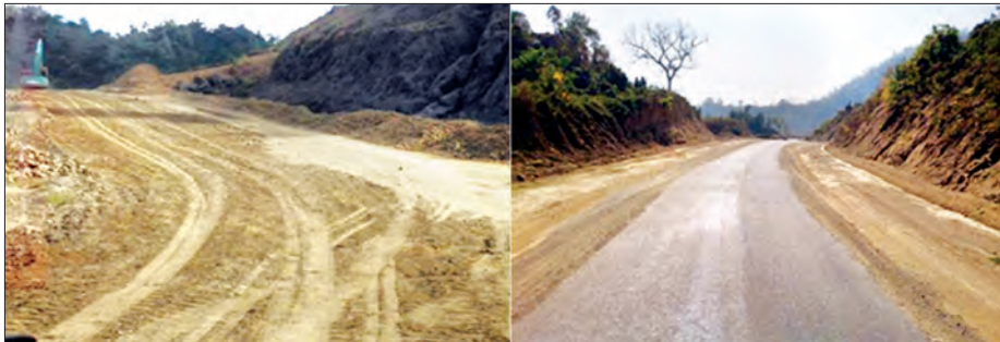
ဘူးသီးတောင်-မောင်တောလမ်း (၁၂ ဒဿမ ၈ ကီလိုမီတာ -၁၃ ဒဿမ ၂ ကီလိုမီတာ)အထိ အကျယ် ၁၂ ပေ ကတ္တရာလမ်းခင်း ခြင်းလုပ်ငန်း မဆောင်ရွက်မီပုံနှင့် ဆောင်ရွက်ပြီးနောက် တွေ့ရပုံ
