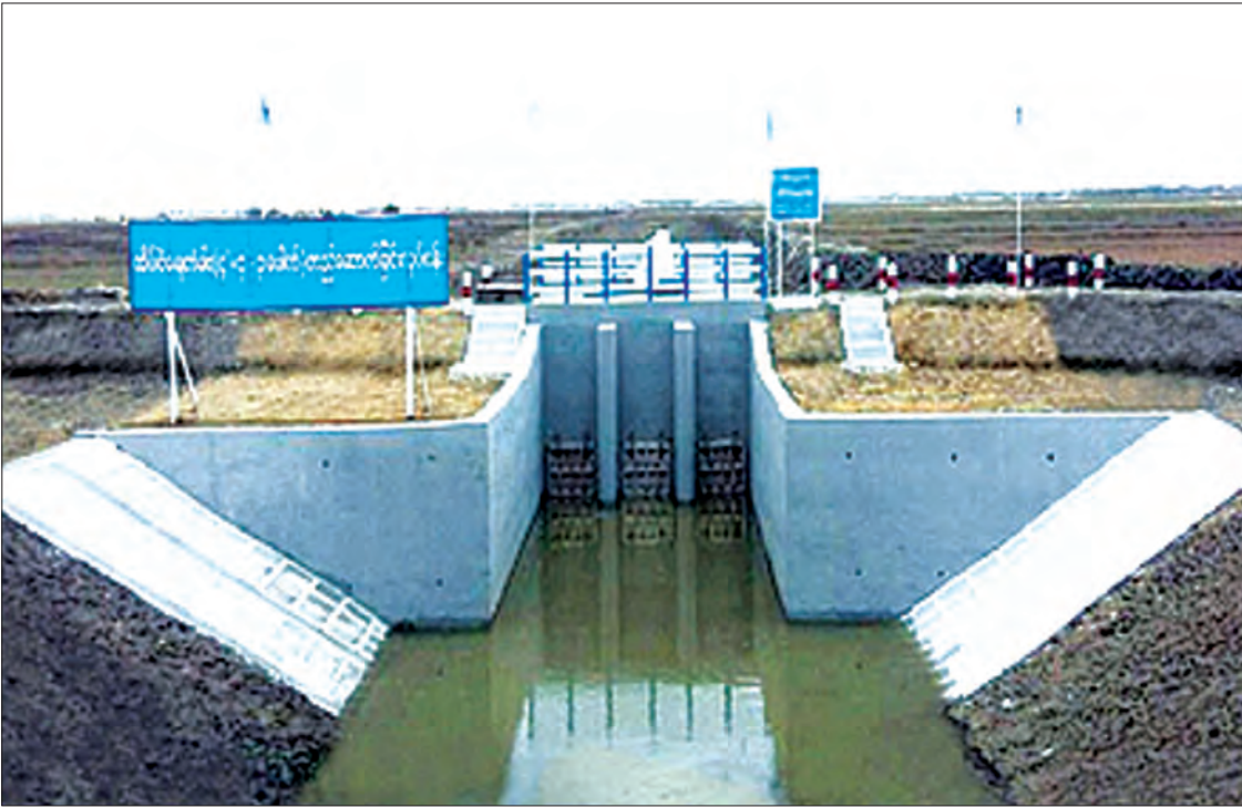
တည်ဆောက်ပြီး ထိပ်ဝဲရေတံခါးအား တွေ့ရစဉ်
