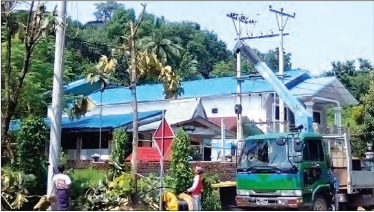
မွန်ပြည်နယ် လျှပ်စစ်ဝန်ကြီးဌာနမှ မော်လမြိုင်မြို့နယ်အတွင်းရှိ ပြည်သူများ ၂၄ နာရီမီးလင်းရေး၊ လျှပ်စစ်အန္တရာယ်မဖြစ်ပွားစေရေးအတွက် အောက်တိုဘာလဒုတိယပတ်က လျှပ်စစ်မီးတိုင်အသစ်နှင့် လျှပ်စစ်မီးကြိုးအသစ်များလဲလှယ်တပ်ဆင်နေစဉ် တင်ထွင်(မော်လမြိုင်)
