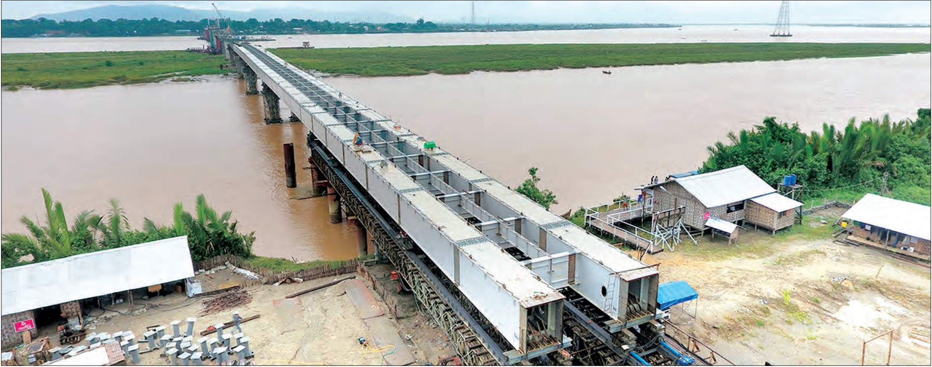
ဘီလူးကျွန်းနှင့် မော်လမြိုင်မြို့ကိုဆက်သွယ်မည့် သံလွင်တံတား(ချောင်းဆုံ) တည်ဆောက်နေမှုကို တွေ့ရစဉ်
