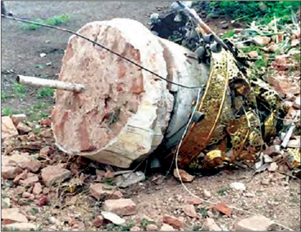
များစွာသောဘုရားစေတီတို့တွင် လွယ်လင့်တကူ နည်းလမ်းမကျ တည်ဆောက်မှုများကြောင့် ငလျင်လှုပ်သည့်အခါ ထိုနောက်တိုးဆောက် အစိတ်အပိုင်းများသည် အောက်သို့ ကျဆင်းတော့သည်။
