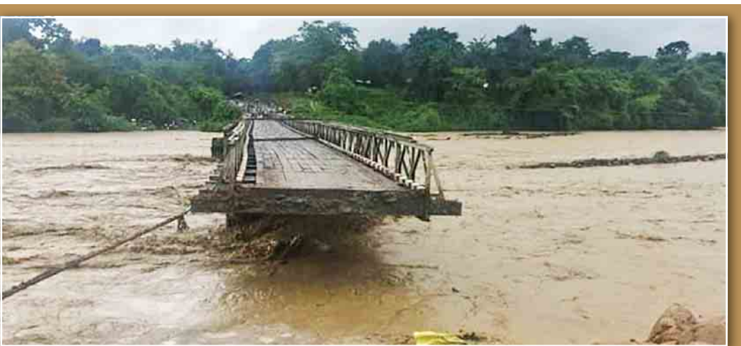
စက်တင်ဘာ ၁၆ ရက်မှစ၍ မိုးအသက်မပြတ်ရွာသွန်းမှုကြောင့် စစ်ကိုင်းတိုင်းဒေသကြီး တမူးခရိုင် ခါမ်းပါတ်မြို့ရှိ အရှည်ပေ ၃၃၀ ရှိ ကန်နံချောင်းတံတား(အမှတ် ၃/၅၈)၏ မြောက်ဘက်ချဉ်းကပ်လမ်း ရေတိုက်စား၍ ယနေ့နံနက်ပိုင်းတွင် ကျိုးပြတ်သွားစဉ်။ [အဆိုပါတံတား ပြတ်တောက်မှုကြောင့် ကလေး-တမူးလမ်း ဆက်သွယ်ရေးပြတ်တောက်ခဲ့ကြောင်း သိရသည်။] ဇော်ဝင်းထွန်း(ပြန်/ဆက်)
