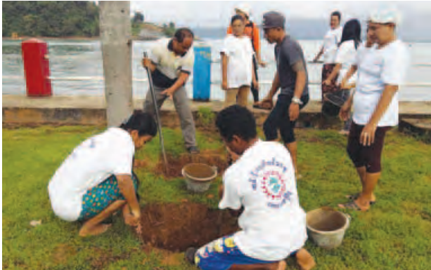
ဒန်းထားရှိမည့် နေရာတွင် ကွန်ကရစ်ဖောင်ဒေးရှင်းတည်ဆောက်နိုင်ရန် မြေတူးနေစဉ်။
