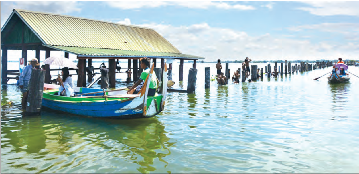
မန္တလေးမြို့၊ အမရပူရမြို့နယ် တောင်သမန်အင်းအတွင်းရှိ ကမ္ဘာကျော် ဦးပိန်တံတား ဧရာဝတီမြစ်ရေဝင်ရောက်မှုကြောင့် အခန်းပေါင်း ၁၁၅ ခန်းရှိ လျှောက်လမ်းကြမ်းခင်းများ ရေကျော်မှုဖြစ်ပွားလျက်ရှိရာ အဆောင်အမှတ် ၃ ဝန်းကျင်တံတားကြမ်းခင်းများ ရေနစ်မြုပ်နေမှုကို ဩဂုတ် ၂ ရက် မွန်းလွဲပိုင်းက တွေ့ရစဉ်။ (ဓာတ်ပုံ - အောင်ဝေပိုင်စေ)
