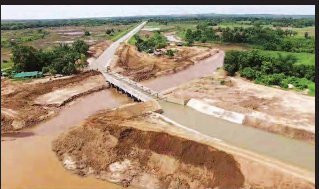
ငမိုးရိပ်တူးမြောင်းမကြီးရှိ ဝါးဒလယ် ကွန်ကရစ်ရေတံလျှောက် အသစ်ပြန်လည်တည်ဆောက်ပြီးစီးမှုကို ဝေဟင်မှတွေ့ရစဉ်။
