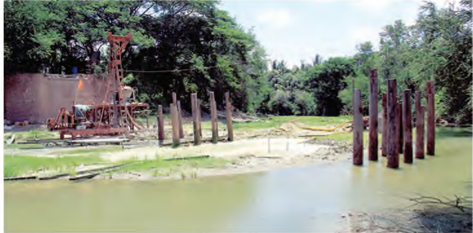
နေပြည်တော်ကောင်စီနယ်မြေ တပ်ကုန်းမြို့ ဘုရင့်နောင်ရပ်ကွက်အတွင်း နှစ်စဉ်ရေတိုက်စား၍ ဟောင်းနွမ်းပျက်စီးလျက်ရှိသည့် တပ်ကုန်း-ပိန်းတောတံတားကို နေပြည်တော်ကောင်စီနယ်အသစ်တည်ဆောက်ရန် ငွေကျပ်သိန်းပေါင်း ၁၀၀၀ အကုန်အကျခံ၍ လမ်း/တံတားအထူးအဖွဲ့(၆) မှ တည်ဆောက်လျက်ရှိစဉ် (လင်းတံတားသည် အရွယ် ၁၂၉ ပေ၊ အကျယ် ၁၂ ပေ၊ အမြင့် ၁၈ ပေရှိပြီး သံကူကွန်ကရစ်တံတားဖြစ်သည်။) (၀၂၀)
