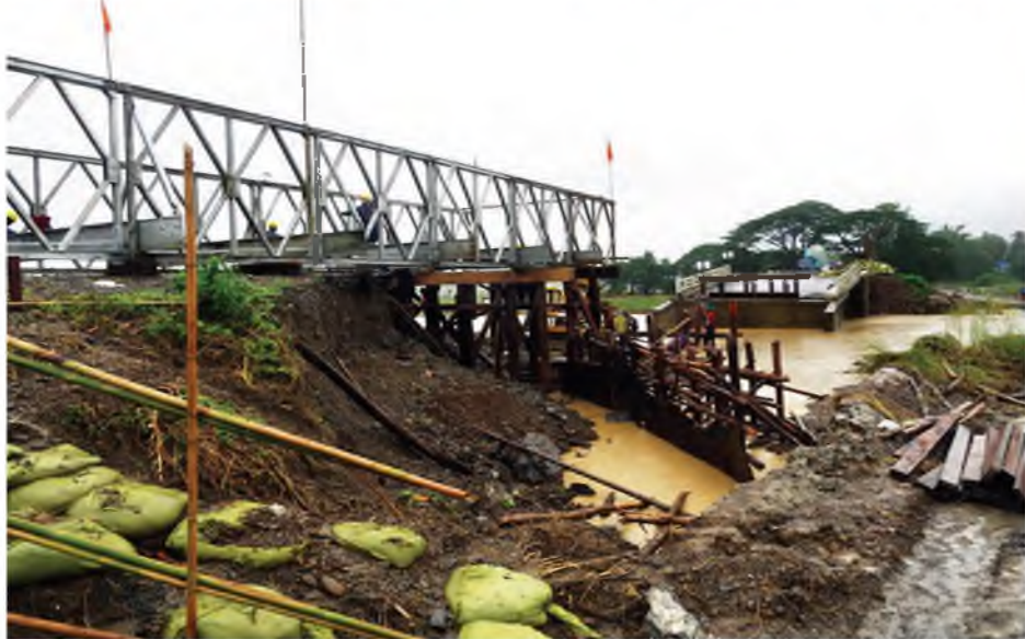
သံတွဲ-ဝှံလမ်း မိုင်တိုင် (၂၆/၆) မှ (၂၇/၀) အကြား တံတားအမှတ် (၁၀/၂၇) ပေ ၄၀ ကွန်ကရစ် တံတားပျက်စီးခဲ့သည့်အတွက် ယာယီဘေးလိတ်တား အစားထိုးတည်ဆောက်ရေးလုပ်ငန်းများကို တွေ့ရစဉ်။ (ဓာတ်ပုံ-ဆောက်လုပ်ရေး)
