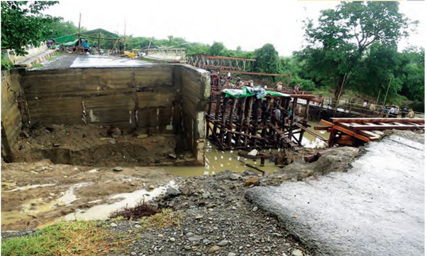
ရခိုင်ပြည်နယ်အတွင်း မိုးသည်းထန်စွာ ရွာသွန်းမှုကြောင့် တောင်ကုတ်-မအီ လမ်းပေါ်ရှိ ငှက်ပျောချောင်းတံတား၊ မအီဘက်ခြမ်းရေတိုက်စားသဖြင့် လမ်းပြတ်တောက်သွားခဲ့ပြီး ကမ်းကပ်နံနံနံကျသွားသဖြင့် ယာယီဘေးလိတ်တားအစားထိုးတည်ဆောက်နေမှုကို တွေ့ရစဉ်။ (ဓာတ်ပုံ-ဆောက်လုပ်ရေး)
