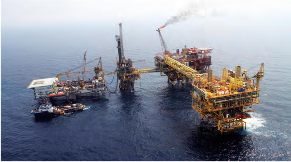
ရဲတံခွန် ကမ်းလွန်သဘာဝဓာတ်ငွေ့ထုတ်လုပ်ရေးစင်ကို တွေ့ရစဉ်။
